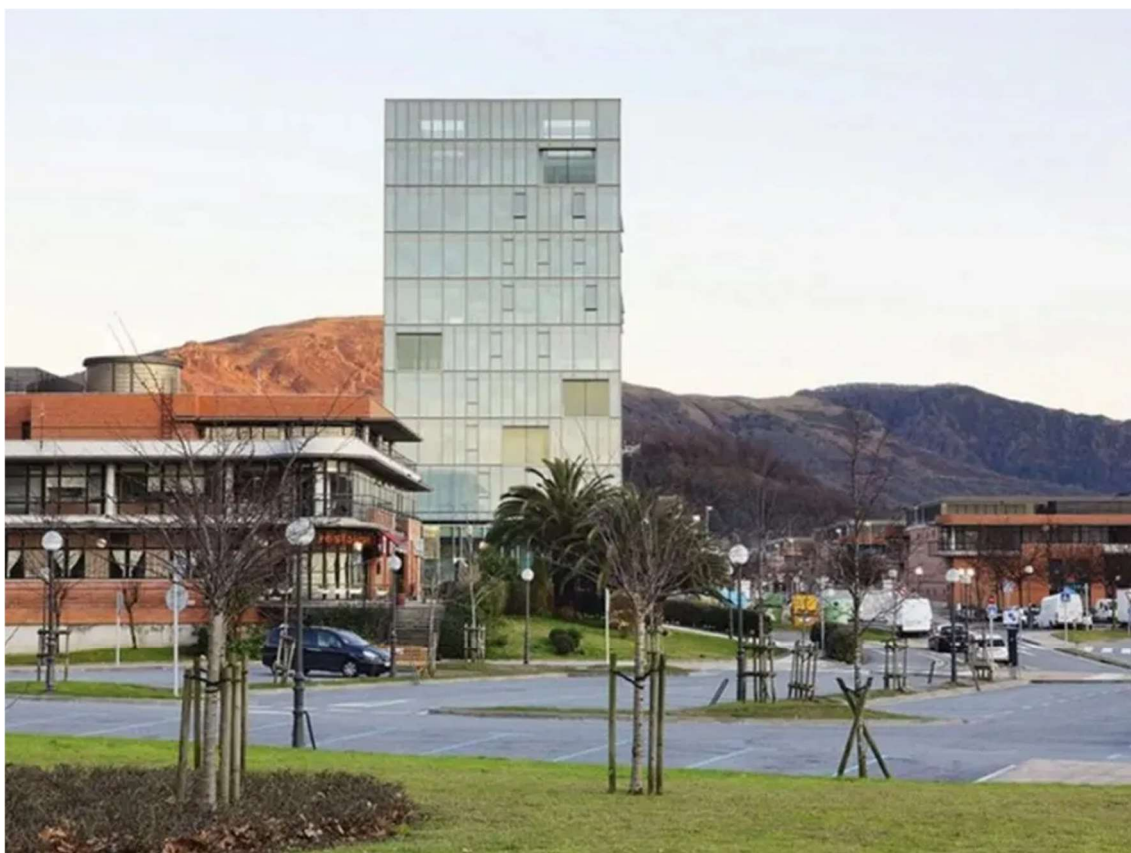
La Aduana se sitúa en el edificio Zaisa de Irún
